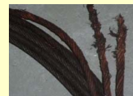
エレベーターのワイヤロープ破断事故
