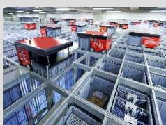
自動倉庫型ピッキングシステム
