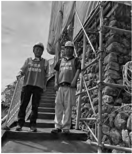
大規模改修現場をパトロール
